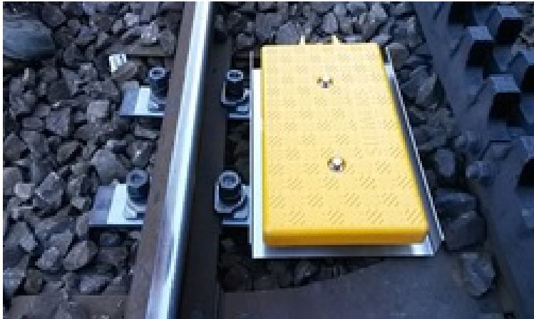
Figura 9: Dispositivo di montaggio per il tratto a cremagliera
