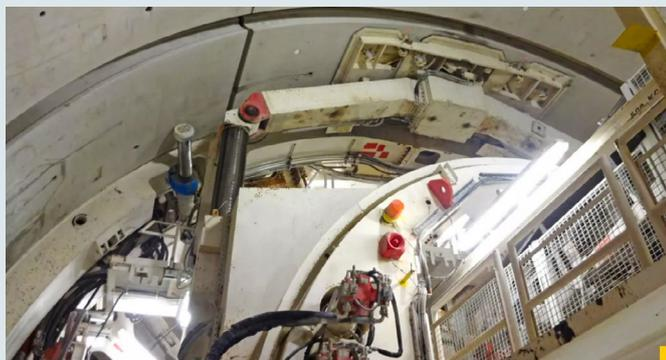
Dans les tunnels, des éléments en béton souvent préfabriqués servent de soutènement et supportent la poussée du terrain. Le dimensionnement de ces éléments, appelés voussoirs, doit être efficient, de sorte que leur fonction soit assurée avec un coût le plus bas possible et un minimum de matériaux.
