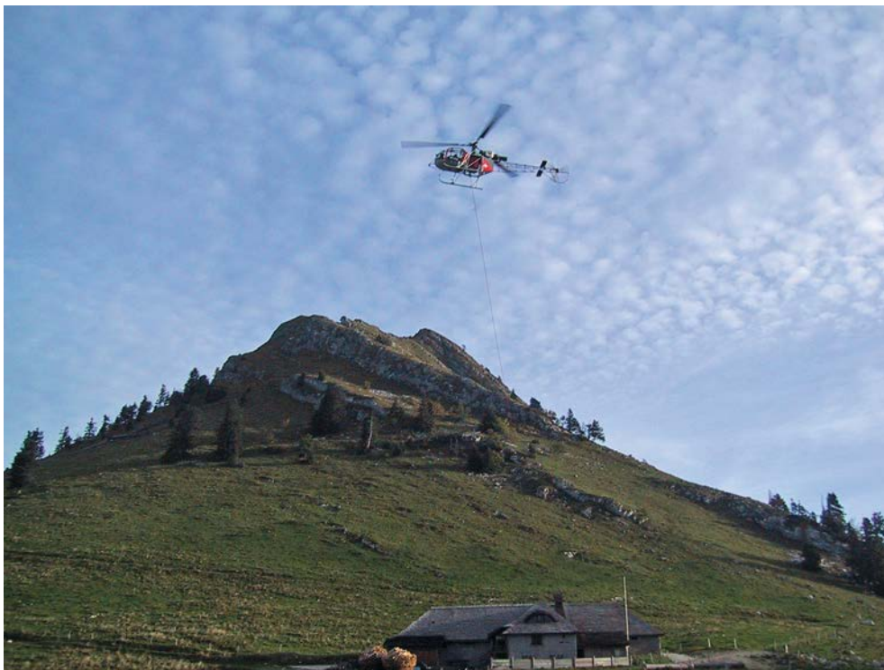
Fig. 4 > L'hélicoptère est très utilisé dans les travaux en altitude. S'il permet de limiter les atteintes au sol (pas de piste de chantier, p. ex.), il représente un facteur important de nuisance sonore.
