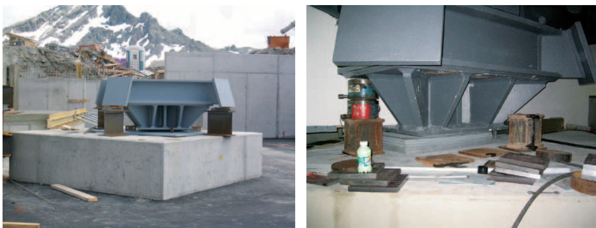
Fig. 48: (à gauche) Système d'appui tripode d'une construction en acier sur une semelle isolée en béton; (à droite) correction d'un tassement à l'aide d'une presse hydraulique et pose de plaques en acier (photos: Markus Walser, Ischgl).
