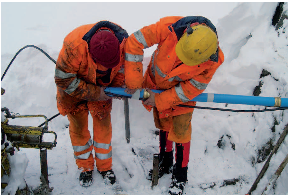
Fig. 36: L'équipe de forage soude et rend étanche un tube Inkrex pendant l'installation dans le trou de forage. Un tuyau destiné à injecter le mortier dans le trou de forage est installé parallèlement au tube Inkrex.
