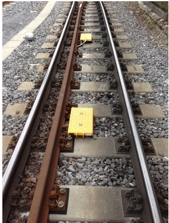
Figure 3: Exemple de montage contre-rail
