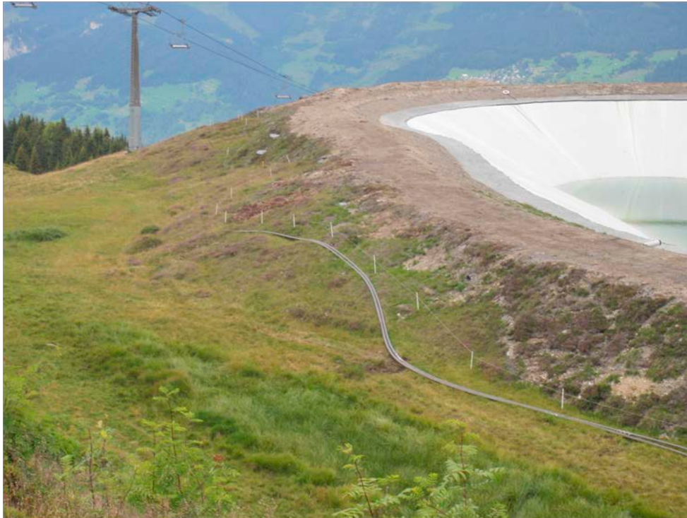
Abb. 10 > Sorgfältige Wiederherstellung nach dem Bau eines Speichersees
