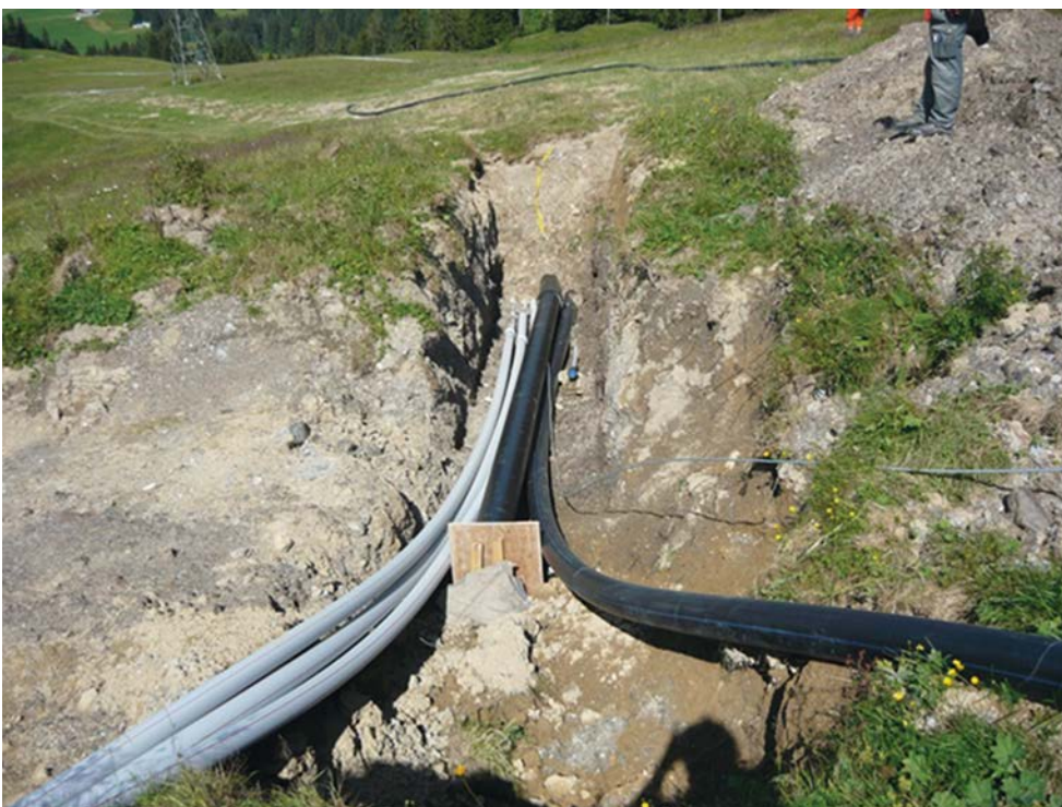
Abb. 11 > Der Leitungsbau zur Speisung der Schnee erzeugende Anlagen kann die natürlichen Lebensräume und den Boden beeinträchtigen.
