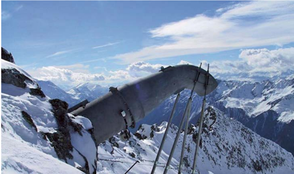
Abb. 13 > Ortsfestes Lawinensprengsystem mit Gasedetonation (Gasex-System)
