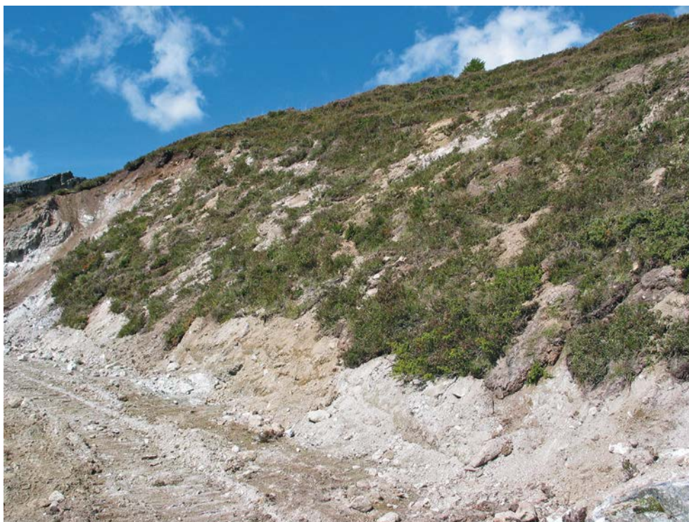
Abb. 57 > Die seitliche Böschung der Zufahrtsstrasse wurde dank der UBB so gestaltet, dass sie sich optimal in das Gelände einfügt und ein möglichst grosser Teil des Aushubmaterials vor Ort genutzt werden konnte.
