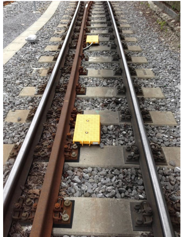
Abbildung 3: Einbaubeispiel Fangschiene
