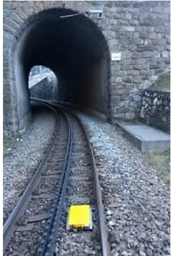
Abbildung 4: Einbaubeispiel Zahnstange
