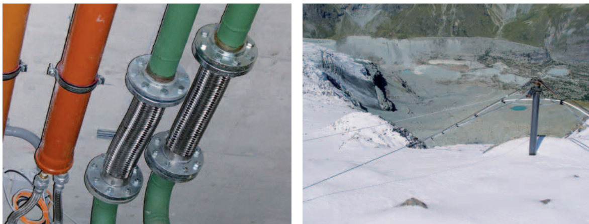
Abb. 51: Zwei Beispiele für flexible Wasserleitungen. (Links) Flexibles Zwischenstück zur Anwendung im Gebäudeinnern. (Rechts) Flexible Wasserleitung über dem Boden hängend.
