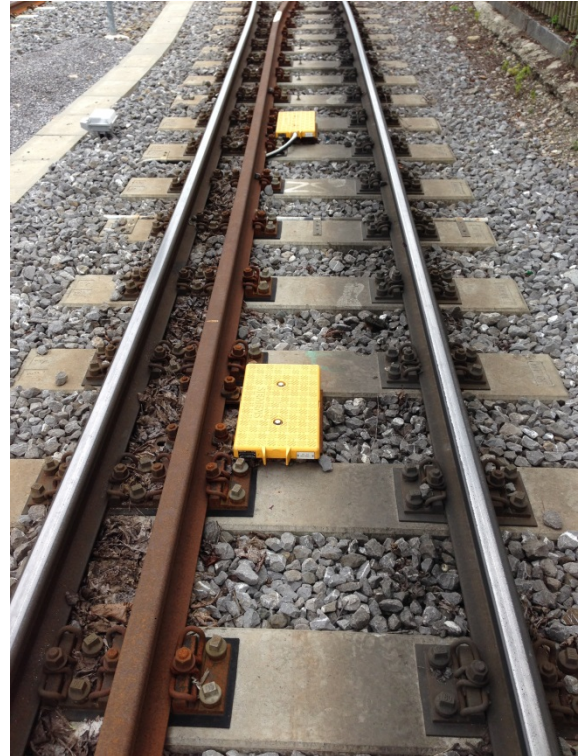
Abbildung 3: Einbaubeispiel Fangschiene
