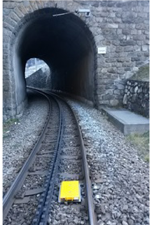
Abbildung 4: Einbaubeispiel Zahnstande
