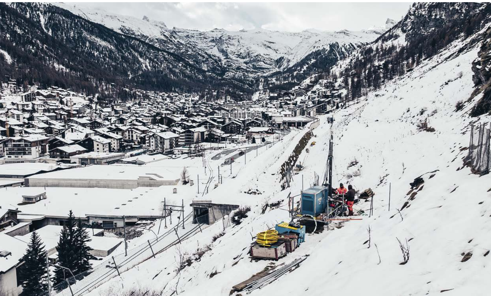
AS35: Täsch–Zermatt, Sondierbohrungen für Neubau Tunnel der MGI
