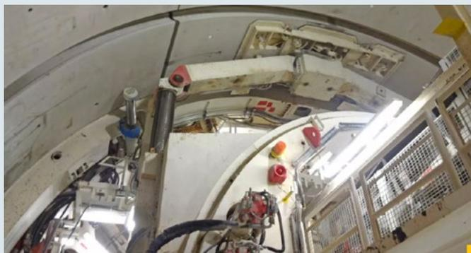
Dans les tunnels, des éléments en béton souvent préfabriqués servent de soutènement et supportent la poussée du terrain. Le dimensionnement de ces éléments, appelés voussoirs, doit être efficace, de sorte que leur fonction soit assurée avec un coût le plus bas possible et un minimum de matériaux.
