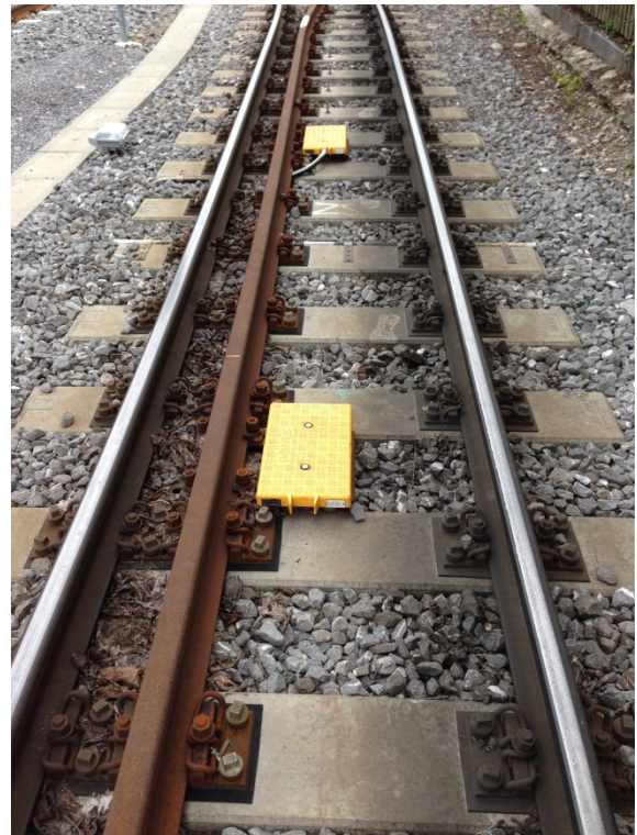
Figura 3: Esempio di montaggio con controrotaia
