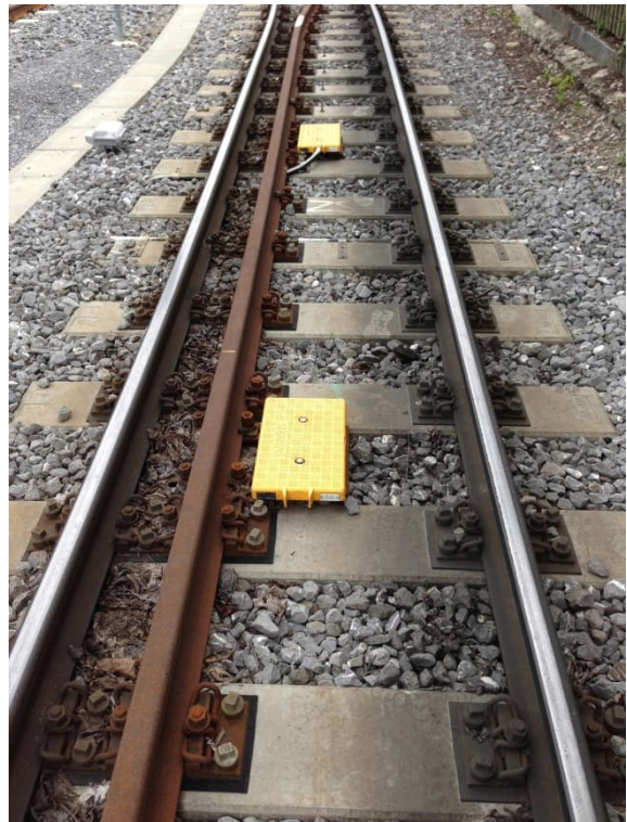
Figura 3: Esempio di montaggio con controrotaia
