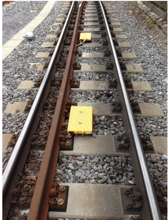
Figura 3: Esempio di montaggio con controrotaia
