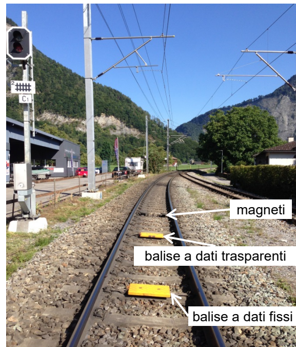
Figura 2: Posizionamento con mantenimento dei magneti
