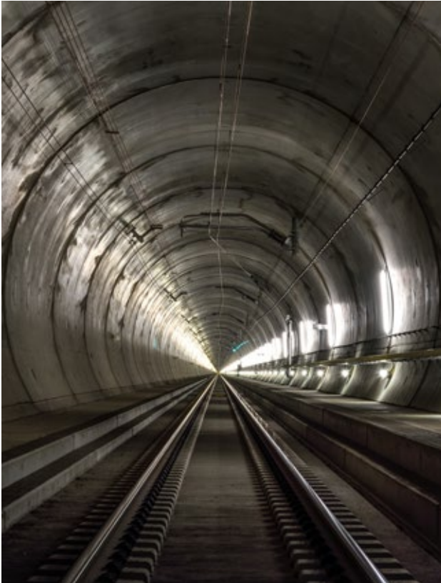
Nella galleria di base del San Gottardo è possibile il trasporto di semirimorchi con altezza agli angoli di quattro metri.
