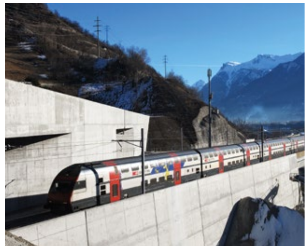
La galleria di base del Lötschberg riduce i tempi di viaggio tra nord e sud.
