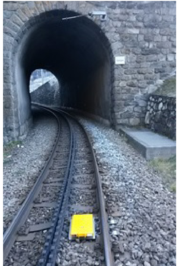
Figure 4: Exemple de montage crémaillère
