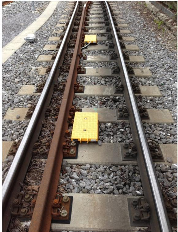
Figure 3: Exemple de montage contre-rail
