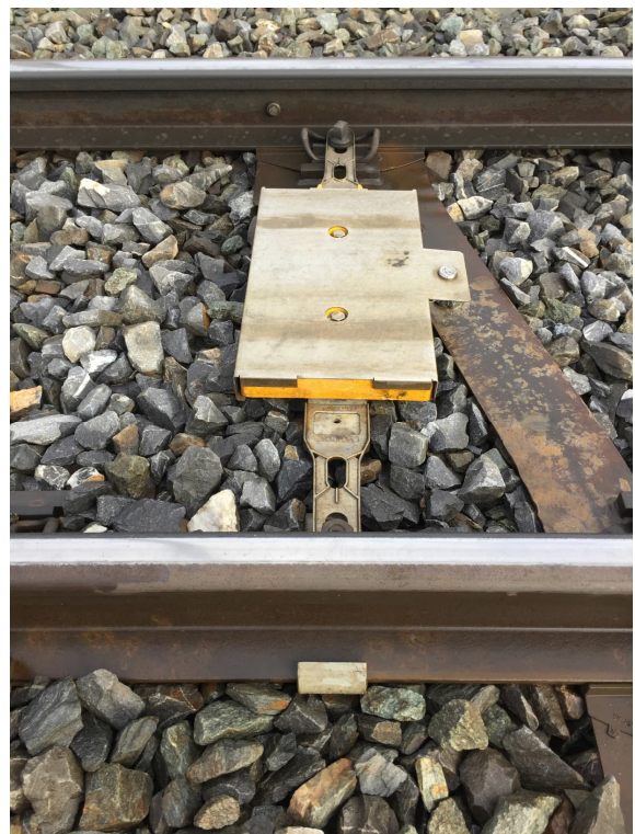
Figure 8: Exemple de montage traverses en Y / balise masquée par une tôle de blindage
