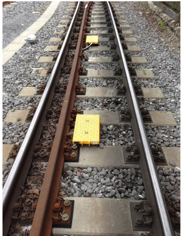
Figure 3: Exemple de montage avec contre-rail
