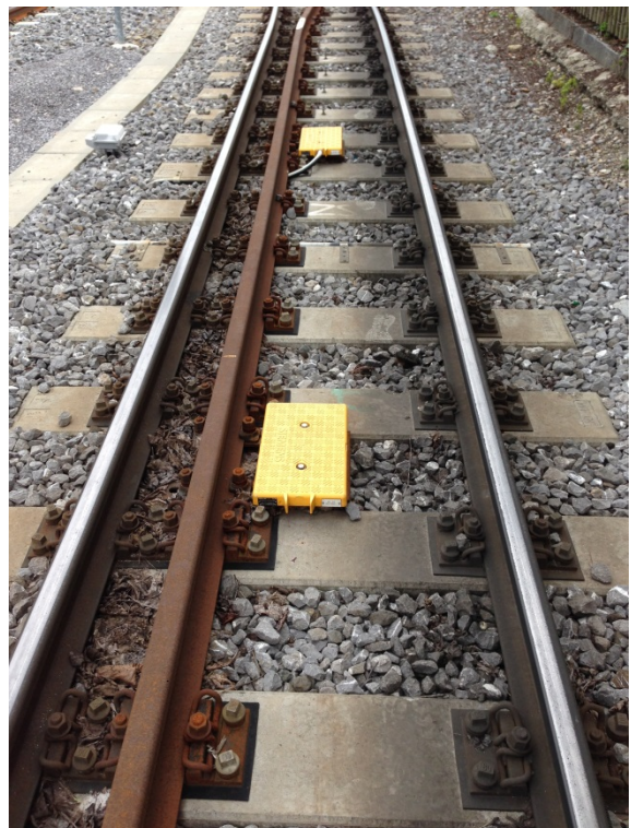
Figure 3: Exemple de montage avec contre-rail
