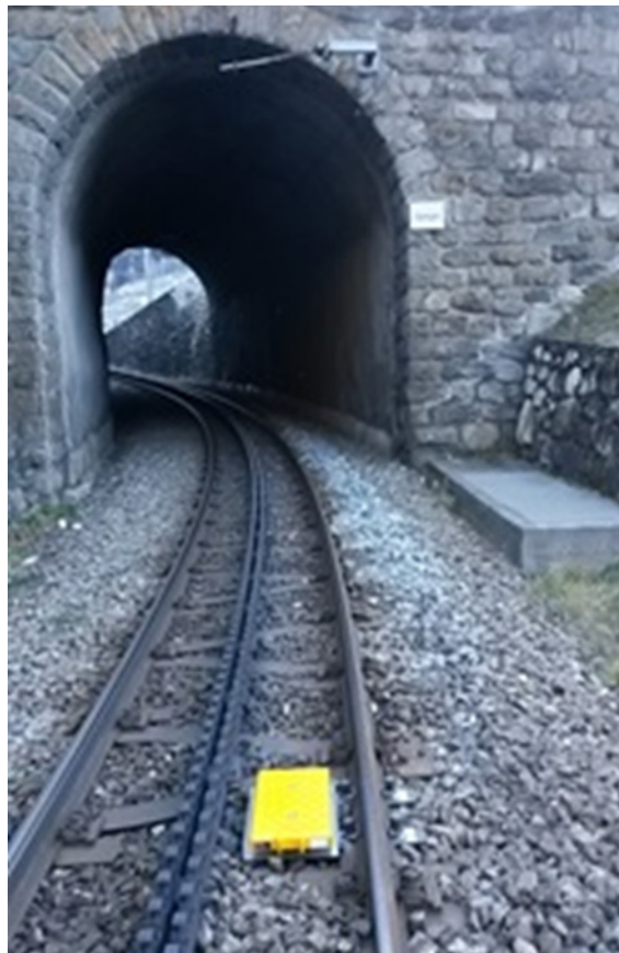
Figure 4: Exemple de montage avec crémaillère
