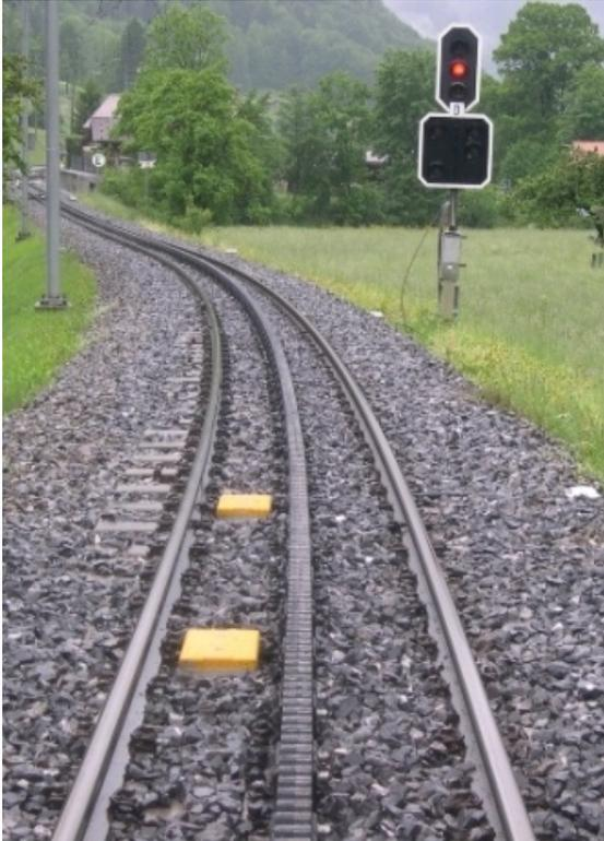
Figure 11 Eurobalises d'un point de l'équipement de voie sur un tronçon à crémaillère
