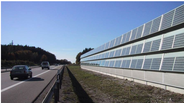
Figure 1 : installation sur l'A96 à Ammersee en Allemagne côté autoroute [12]
