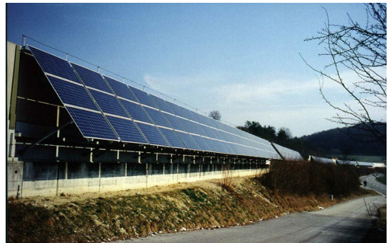
Figure 2 : installation sur l'A2 Giebenach en Suisse côté opposé à l'autoroute [12]
