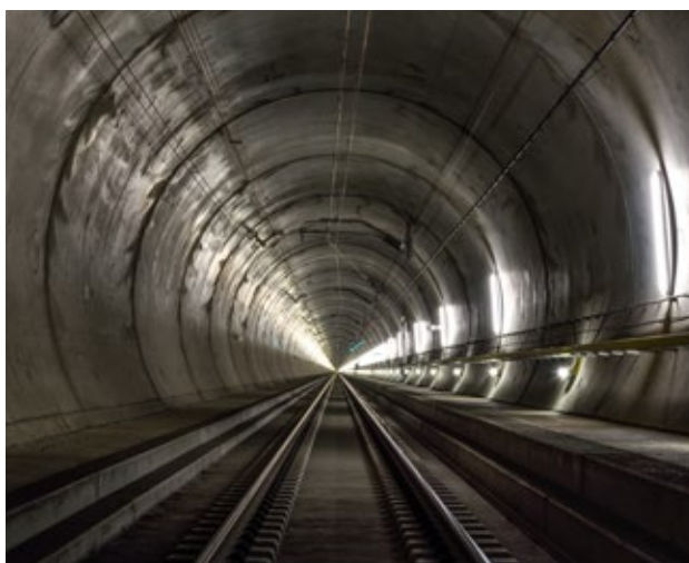
Les transports avec une hauteur aux angles de 4 mètres sont possibles dans le tunnel de base du Saint-Gothard.
