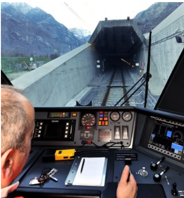
Le tunnel de base du Saint-Gothard est le plus long tunnel ferroviaire du monde.
