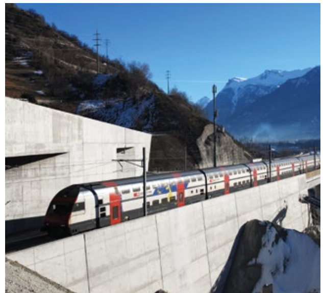
Le tunnel de base du Loetschberg réduit les temps de parcours entre le nord et le sud.
