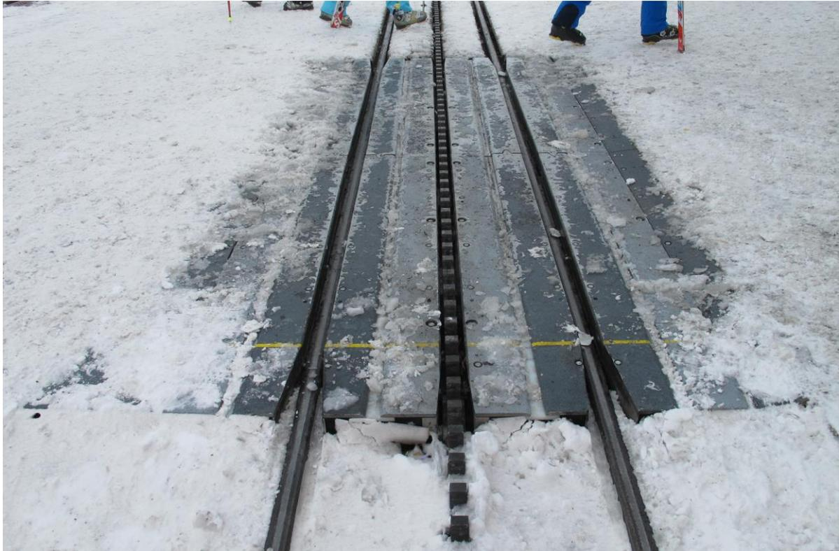
*Abbildung 20: Zustand vor Inspektion ungereinigt mit Schnee und Eis in den Dilatationsnuten*
