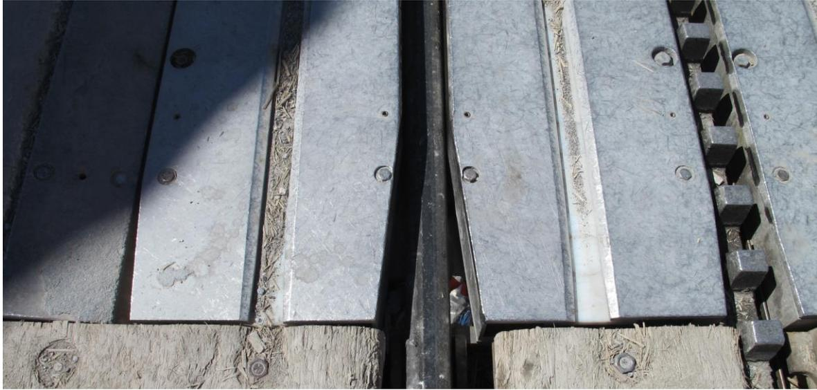
*Abbildung 22: Zustand vor Inspektion ungereinigt mit Split und Sand in den Dilatationsnuten*
