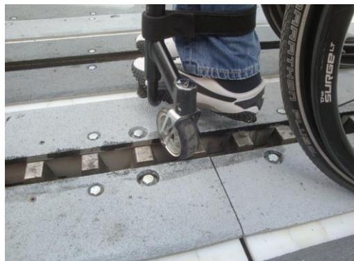
Abbildung 13: Kleines Rad bei Zahnstange
