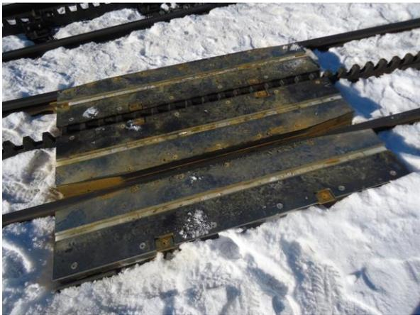
Abbildung 8: Vorversuchsübergang mit Rost
