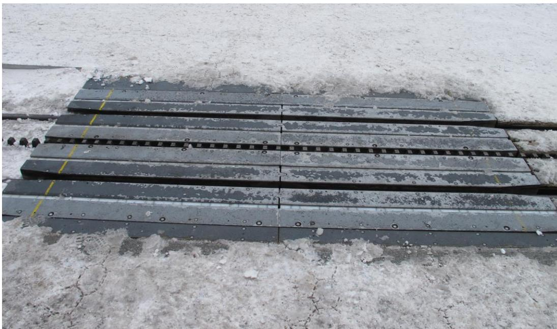
*Abbildung 21: Zustand Antirutschbelag (Abtragung durch Schneeketten)*
