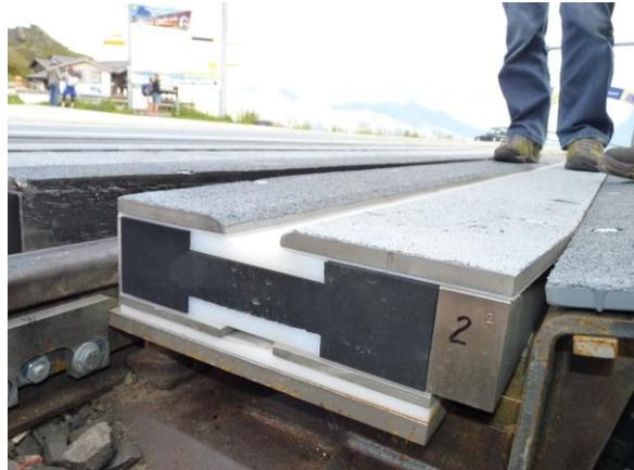
Abbildung 11: Querschnitt eines Elements
