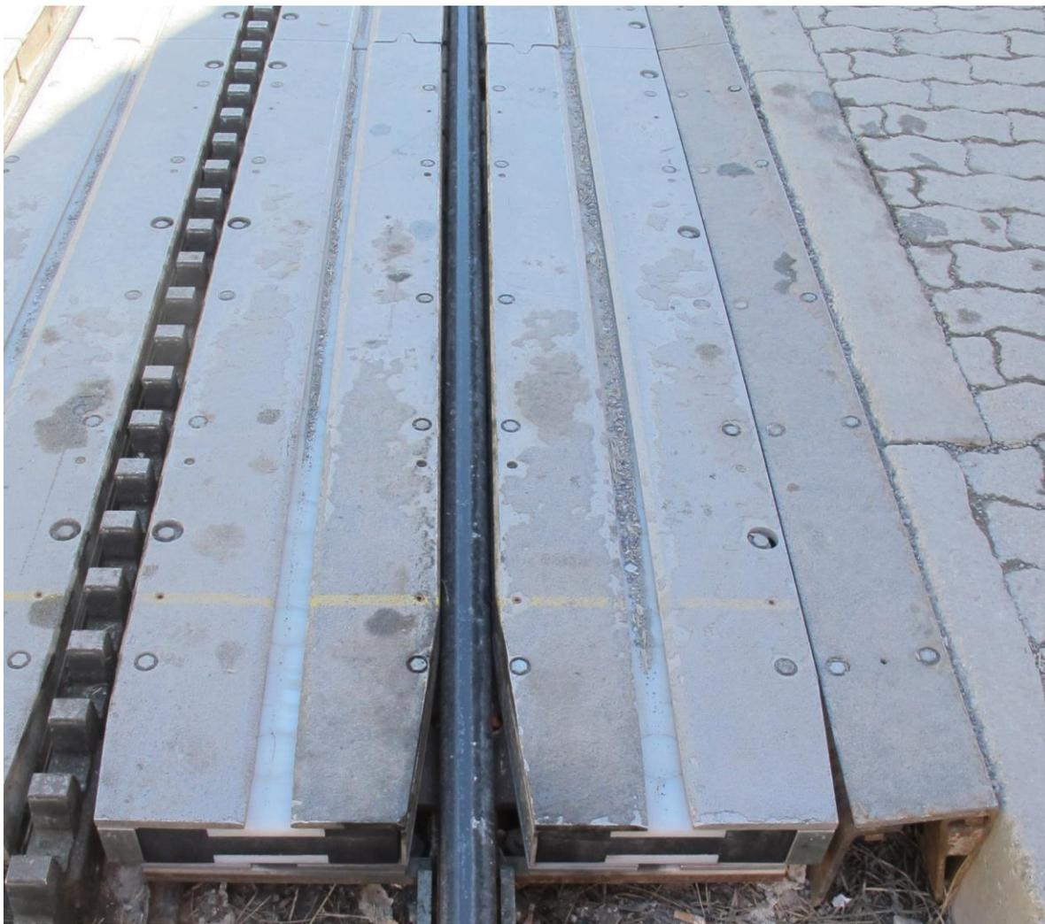
*Abbildung 23: Unterschiedlicher Abtrag des Antirutschbelages*
