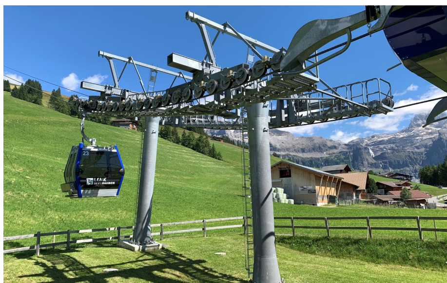
En 2022, les spécialistes de l'OFT ont procédé à 129 contrôles d'exploitation d'entreprises de transport à câbles.
