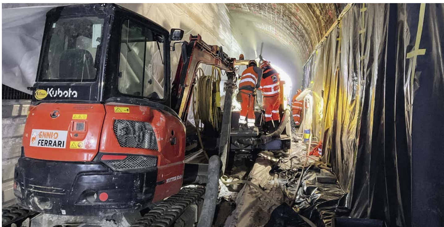
4mK: Travaux de construction tunnels sur la ligne de faite du Ceneri
