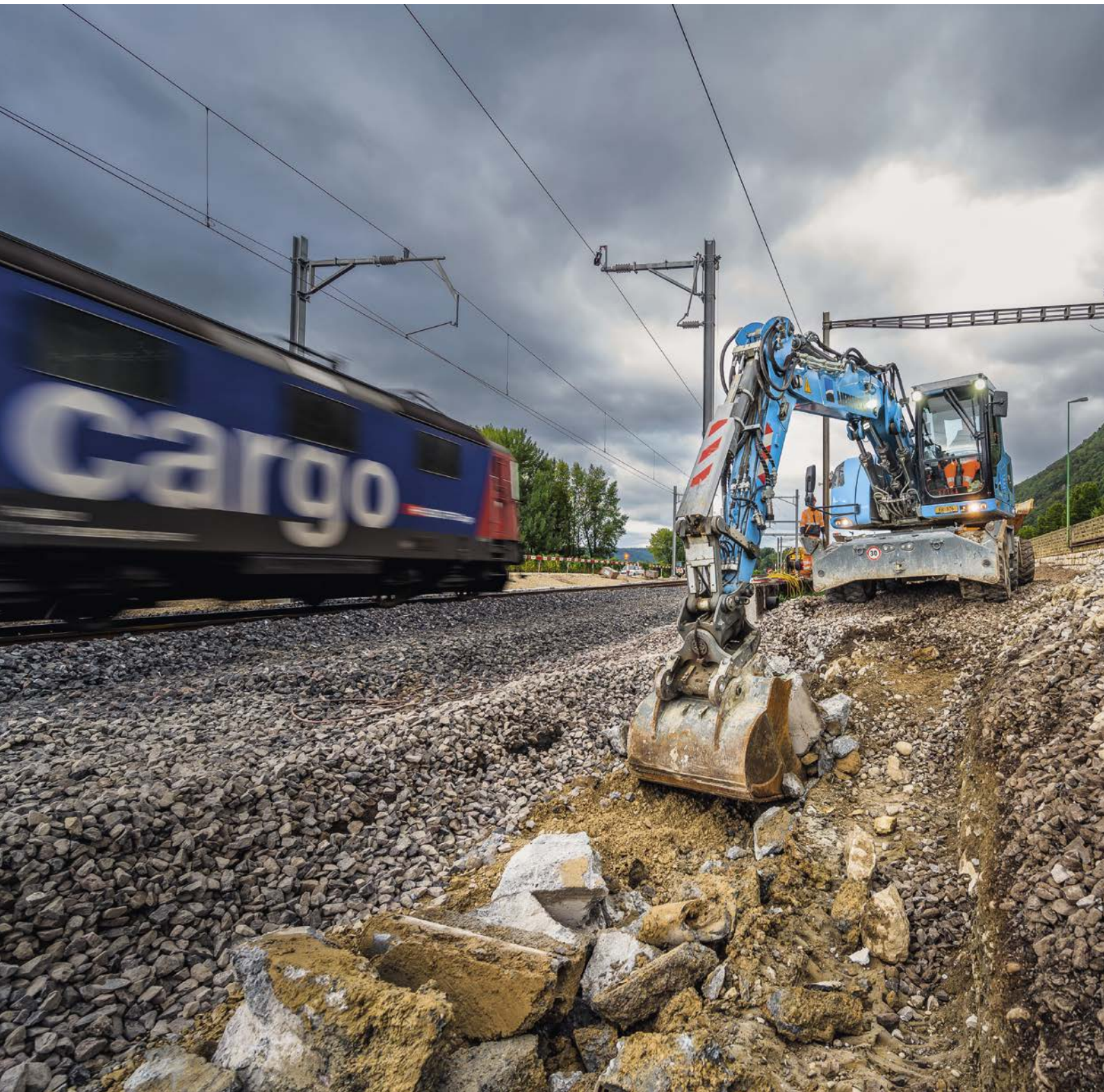
EA25: Gléresse-Douanne, nouveau tunnel à double voie
