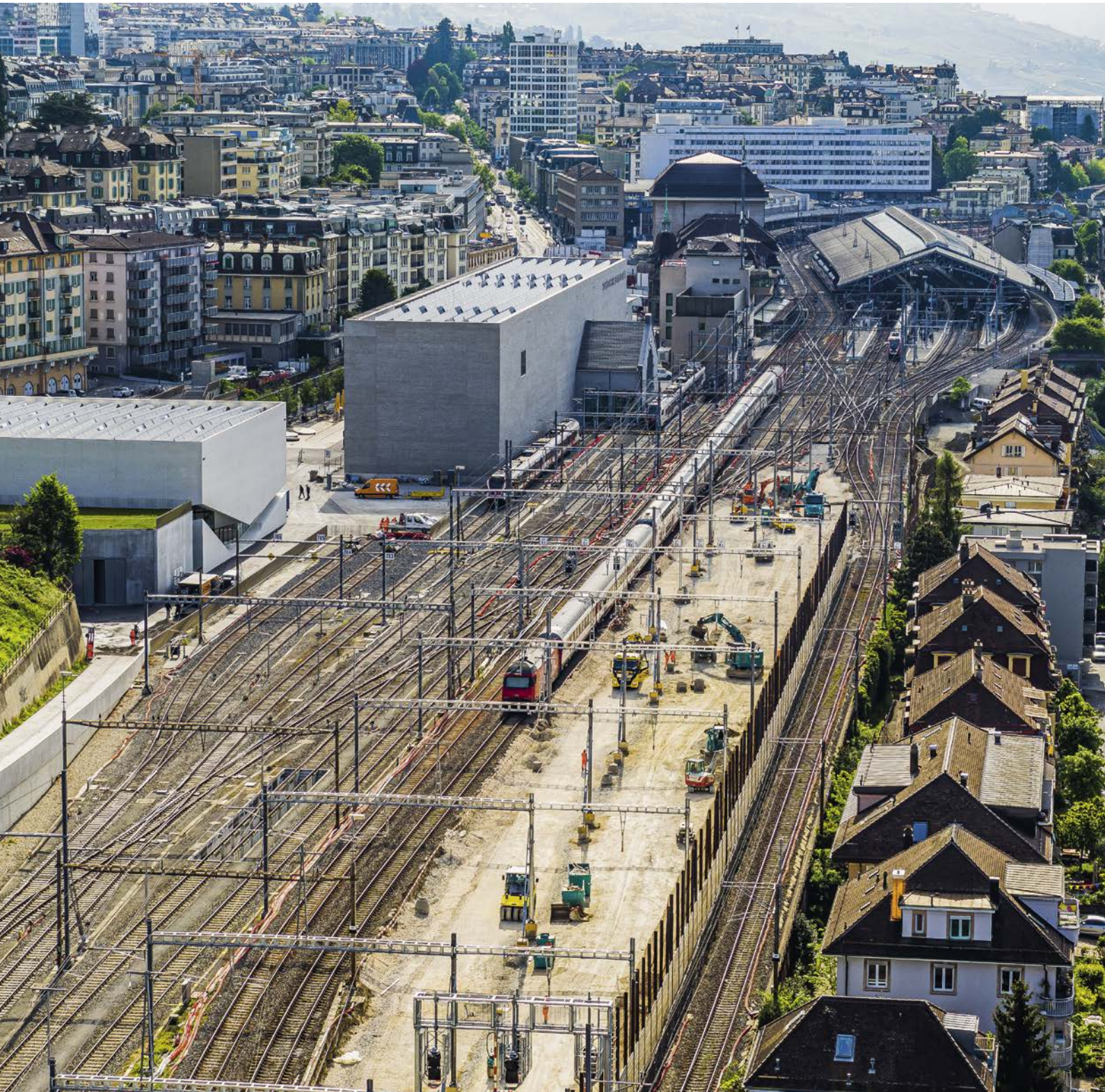
ZEB : Lausanne, aménagement de la gare, Tête Ouest
