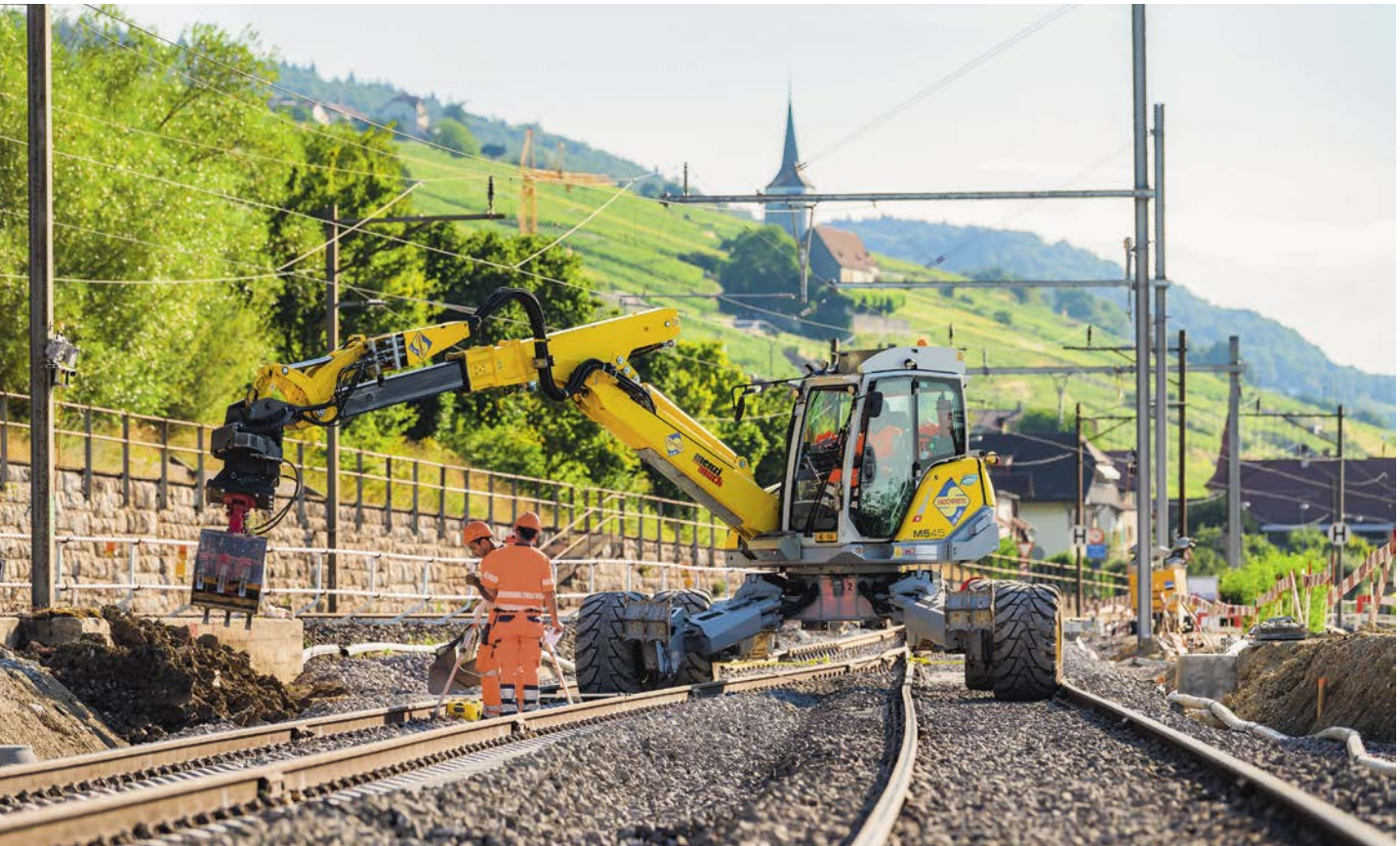
EA25: Gléresse-Douanne, nouveau tunnel à double voie
