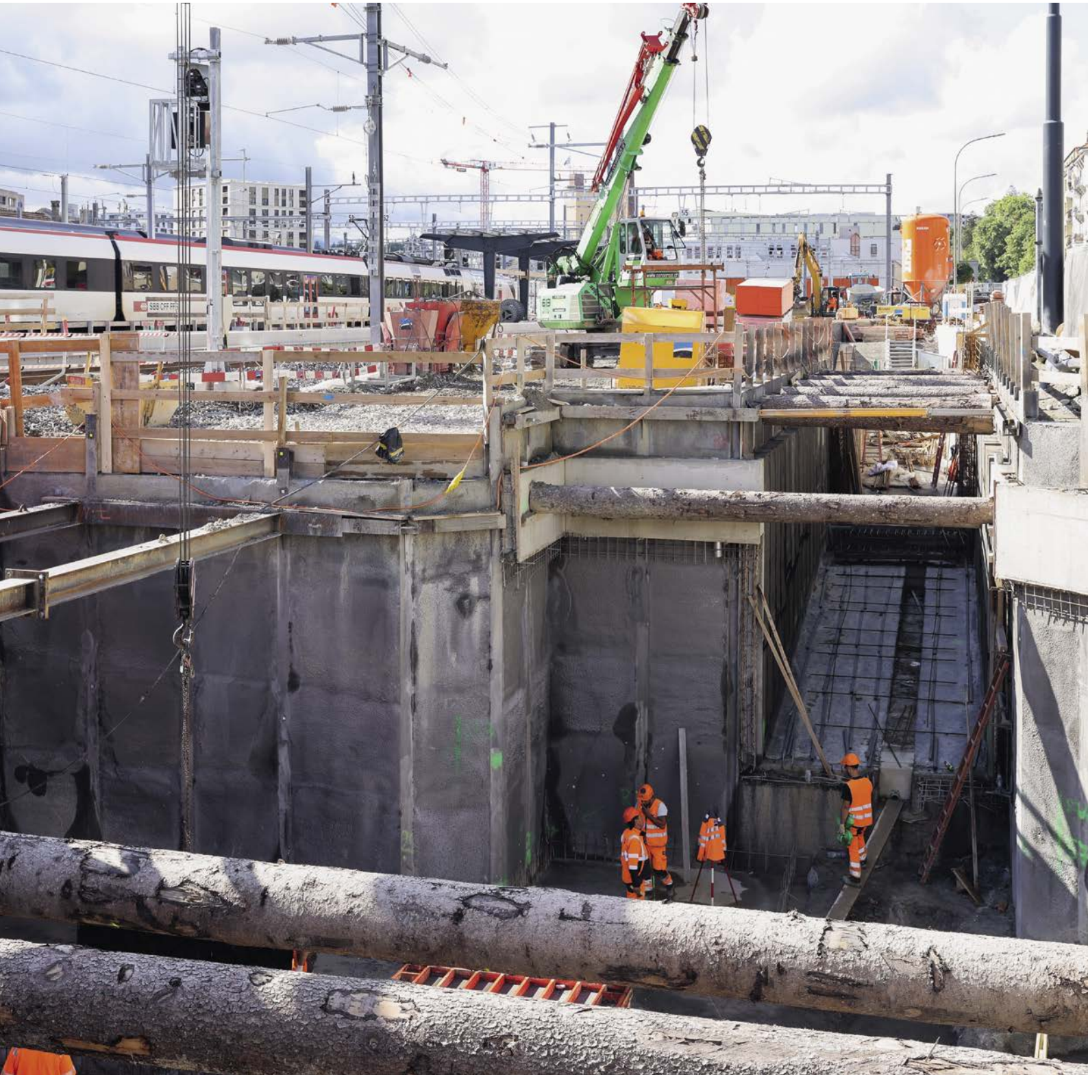
ZEB : Fribourg, travaux de construction 2e passage inférieur pour piétons
