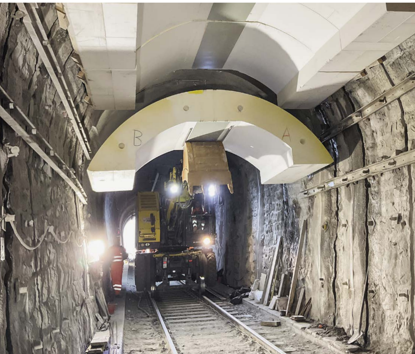
4mK: Ligne de faite du Ceneri, Élargissement du profil d'un tronçon de tunnel
