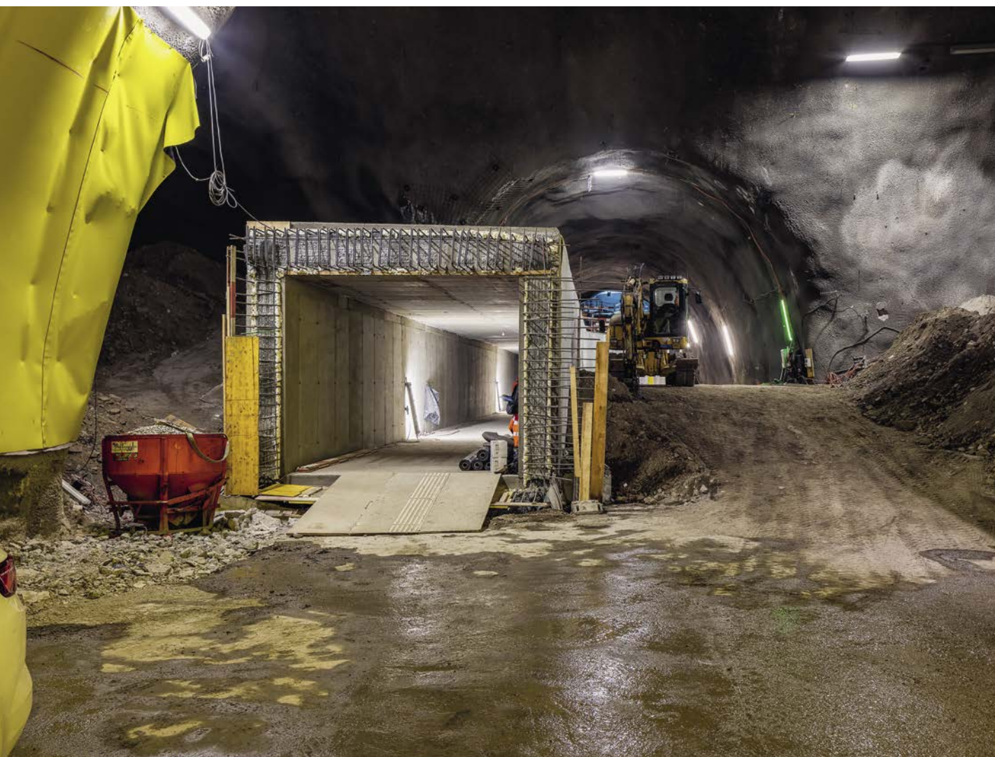
NLFA: Galeries d'accès Sigirino aux tubes de circulation CBT
