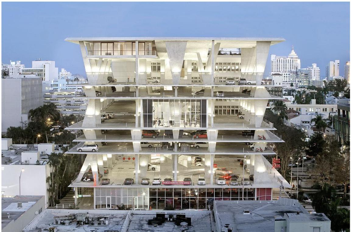
Abbildung 42: Das Parkhaus 1111 Lincoln Road in Miami Beach verfügt über eine offene Betonstruktur ohne Fassade. Die hohen Parkebenen lassen sich als Veranstaltungsort nutzen. Das Erdgeschoss vom Parkhaus wird für Läden, Restaurants und Bars genutzt, im Obergeschoss sind Wohnungen untergebracht.
