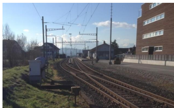
Situation Bahnhof Eschenbach.
