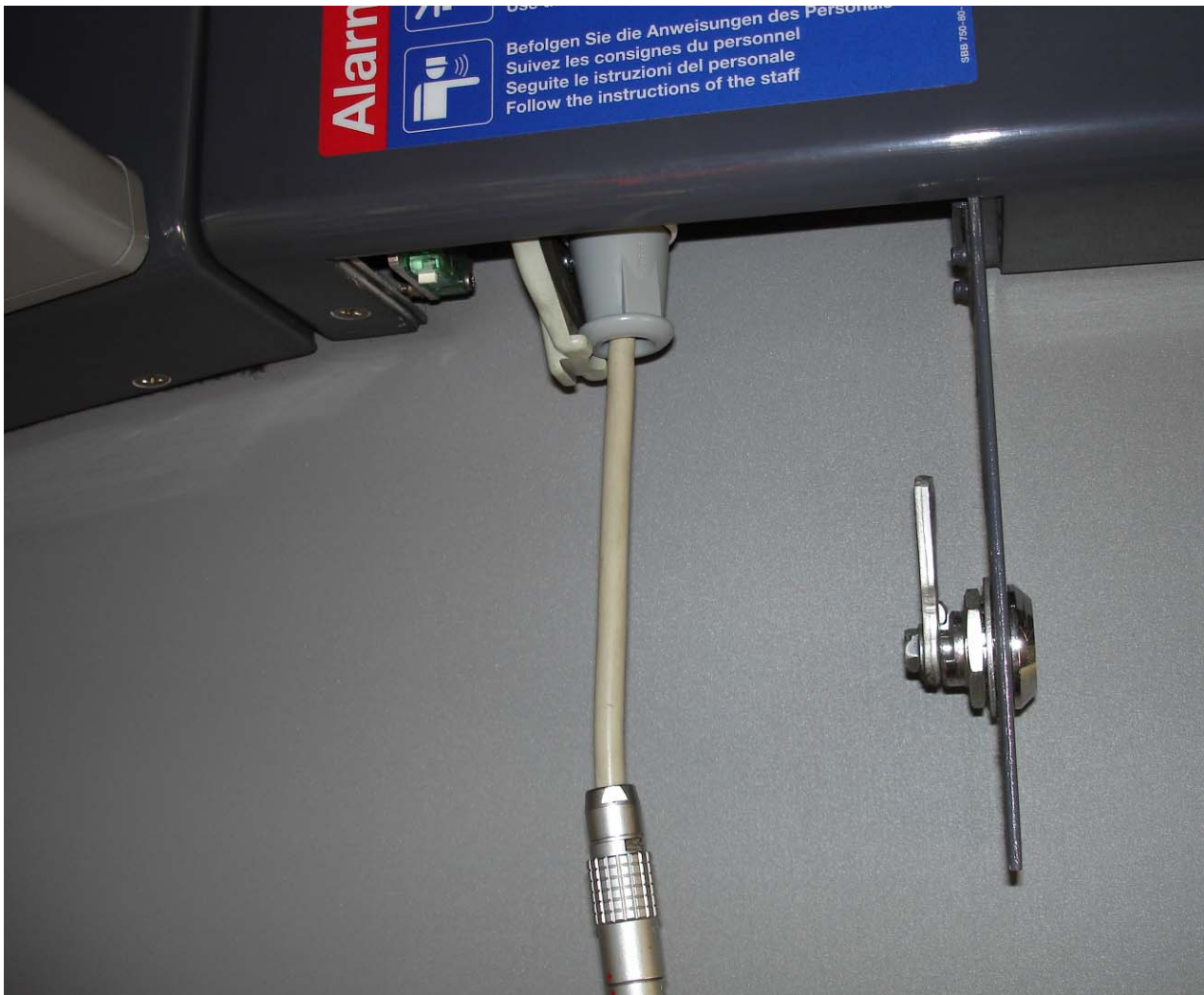
Einspeiseanschluss für den Musikkoffer der SBB, Steckerbelegung nach UIC Kodex 568 VE. Dieser Anschluss ist im IC 2000 DOSTO und im FLIRT vorhanden. Beim DTZ fehlt er.
