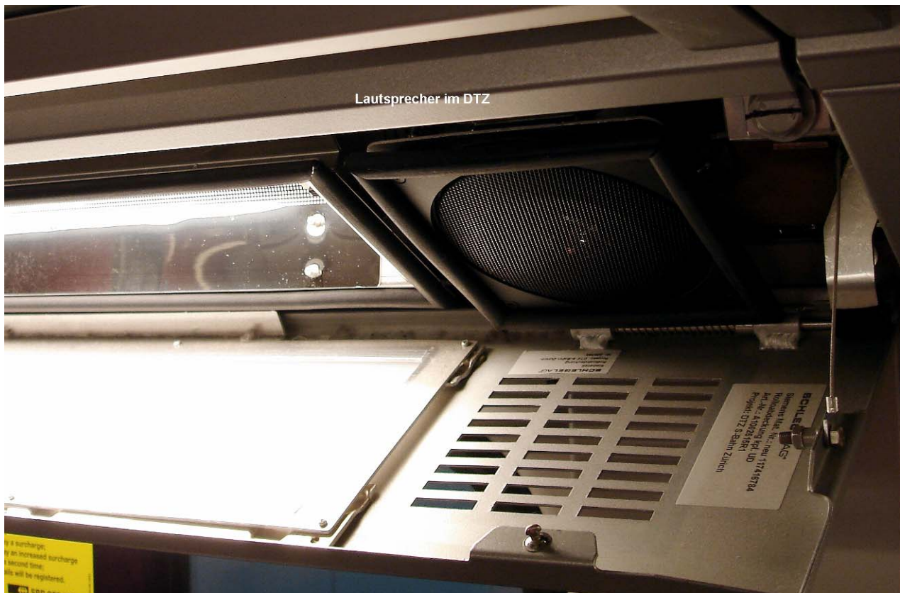
Lautsprecher im DTZ mit Schlitzabdeckung (mechanisch geschützt)
