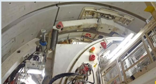
Bei Tunnels werden zur Ausbruchsicherung und zur Aufnahme von Gebirgslasten häufig vorgefertigte Betonelemente verwendet. Diese sogenannten Tübbinge sollen effizient dimensioniert werden, sodass ihre Funktion mit möglichst tiefen Kosten und geringem Materialaufwand gewährleistet wird.
