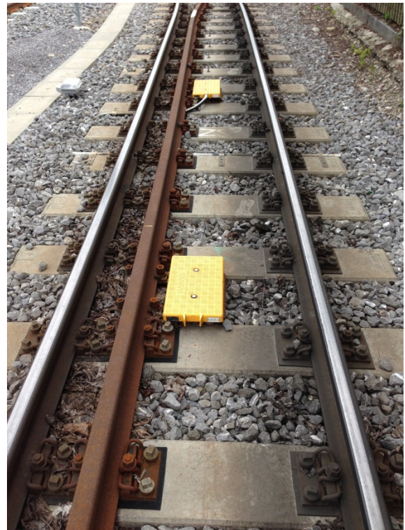
Abbildung 3: Einbaubeispiel Fangschiene
