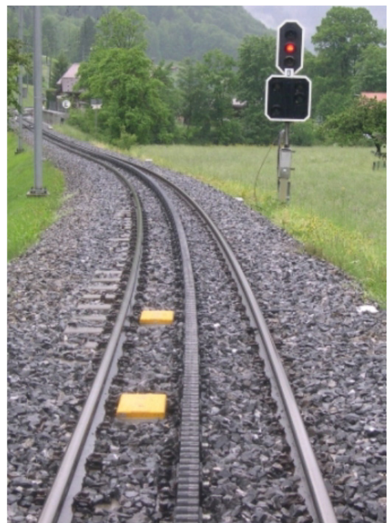
Abbildung 4: Einbaubeispiel Zahnstange
