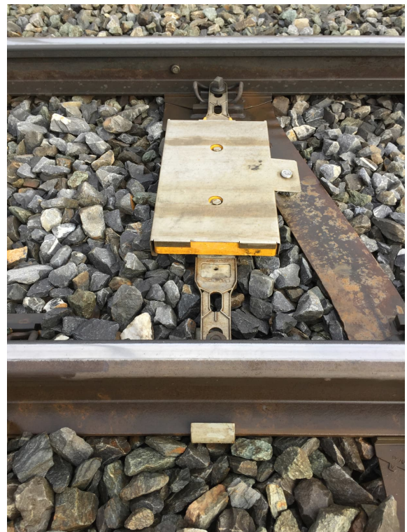
Abbildung 8: Einbaubeispiel Y-Schwellen / Eurobalise mittels Abschirmblech abgedeckt
