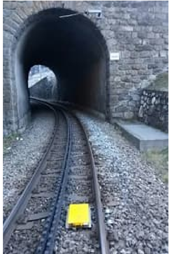
Abbildung 4: Einbaubeispiel Zahnstange
