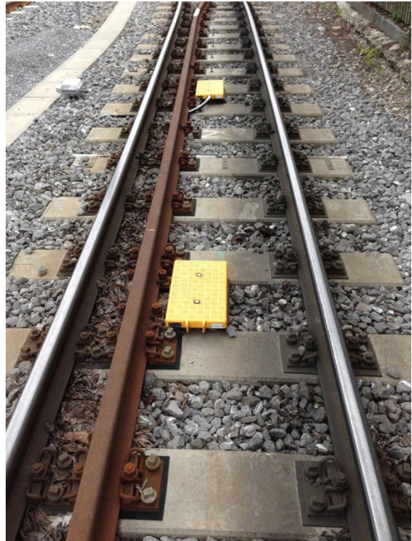
Abbildung 3: Einbaubeispiel Fangschiene
