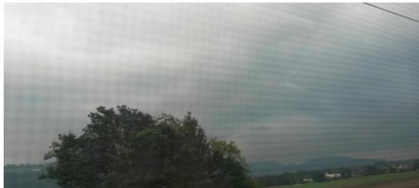
Abbildung 8: Fenster mit wabenförmiger Strukturierung der Wärmeschutzbeschichtung. Quelle: RRR.de
