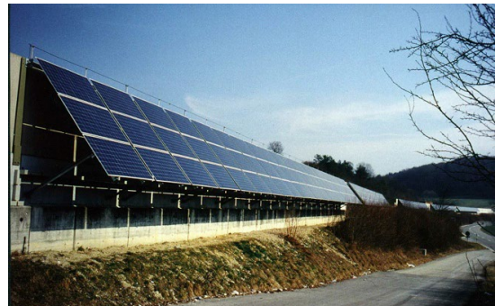
Abbildung 2: Anlage an der A2 in Giebenach, Schweiz, Aussenseite der LSW [12]
