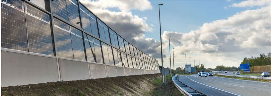
Abbildung 3: LSW mit bifazialen Solarmodulen entlang der A50 in Uden, Niederlande, im Rahmen des Projekts Solar Highways [10]
