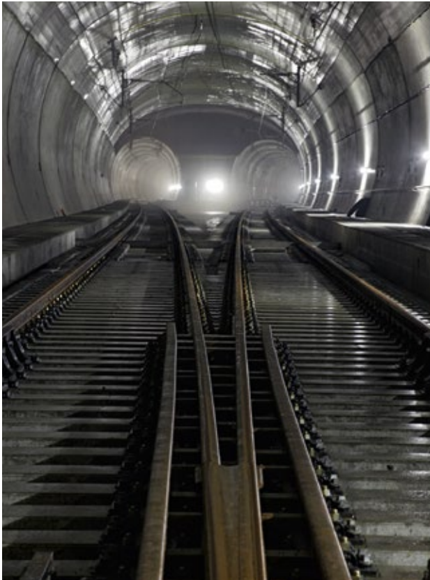
Der Lötschberg-Basistunnel verkürzt die Fahrzeiten zwischen der Schweiz und Italien.
