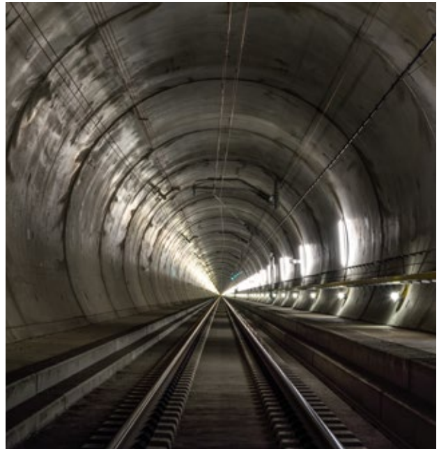
Im Gotthard-Basistunnel sind Transporte mit 4 Metern Eckhöhe möglich.
