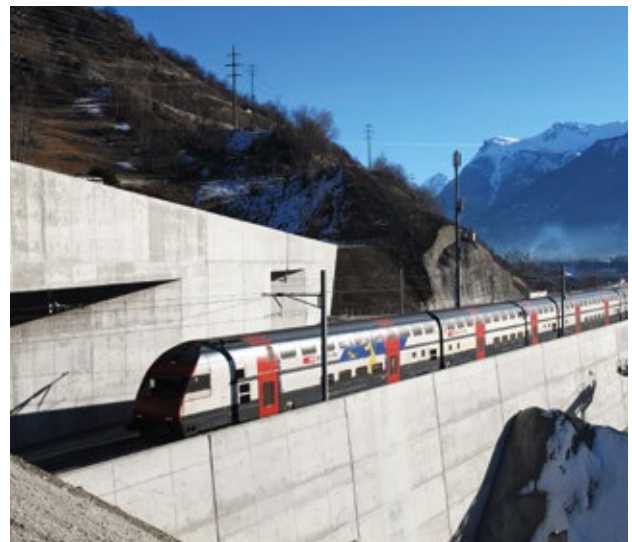
Der Lötschberg-Basistunnel verkürzt die Reisezeiten zwischen Nord und Süd.
