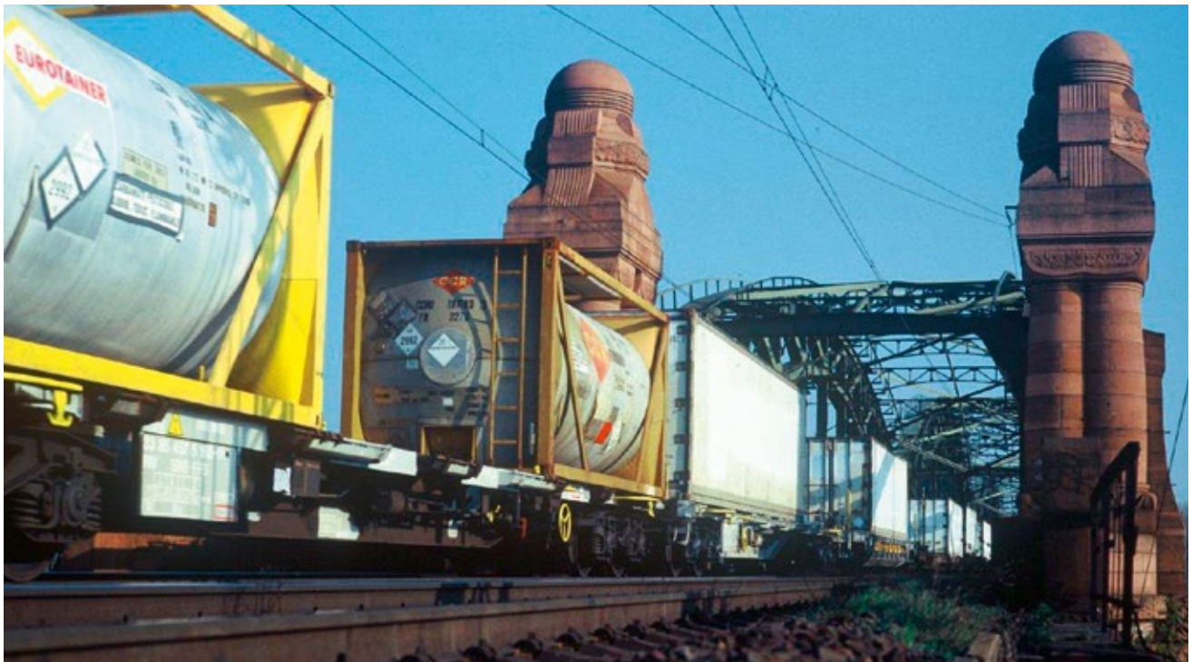
Der Korridor Rhein-Alpen führt durch das industrielle Herz Europas.
