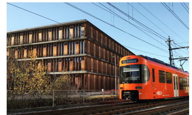
Das BAV-Gebäude heute. Es steht in Ittigen, direkt an der RBS-Bahnlinie.
