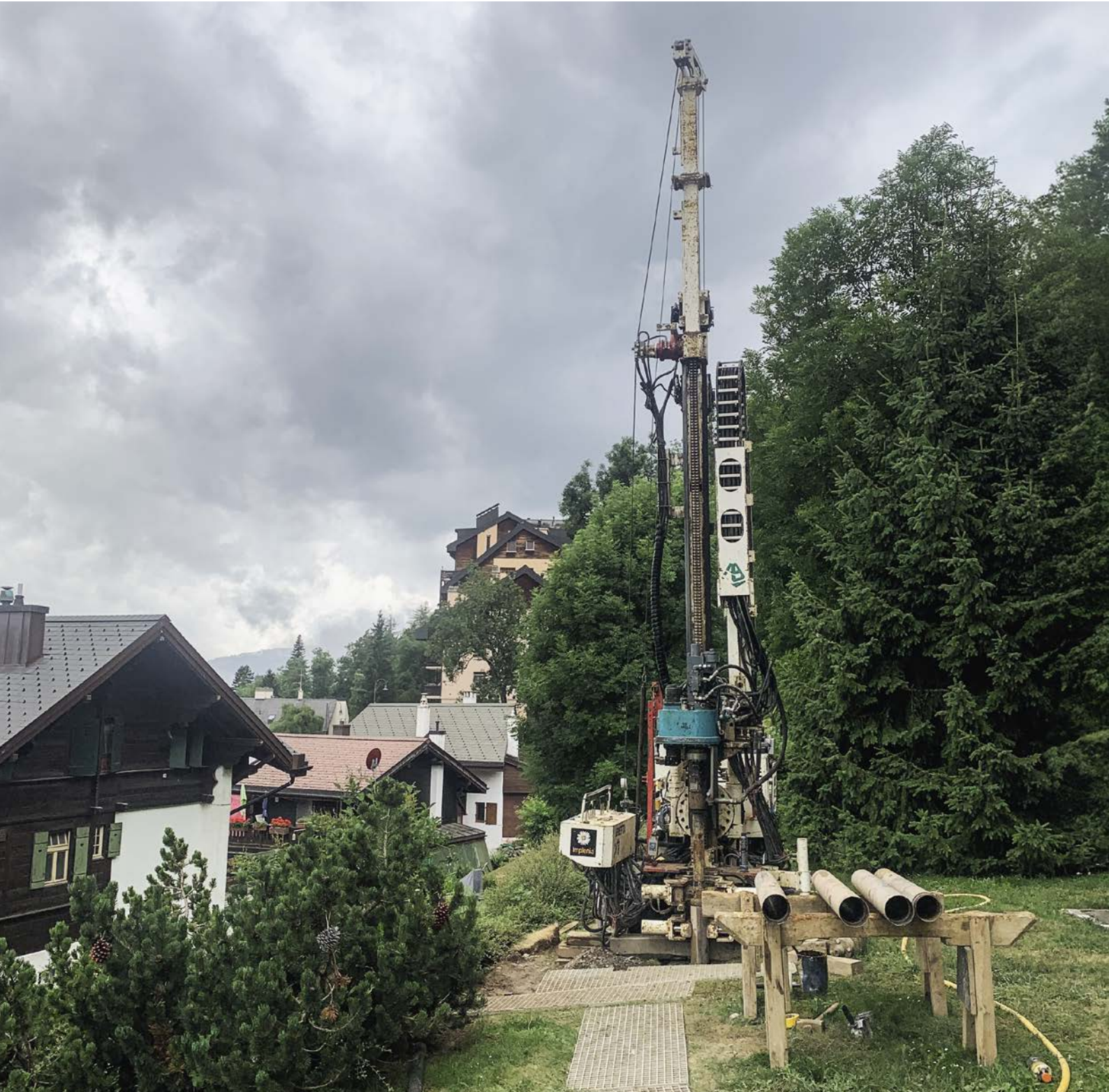
FA35: Leysin-Village–Leysin-Télécabine, nuova linea ferroviaria
