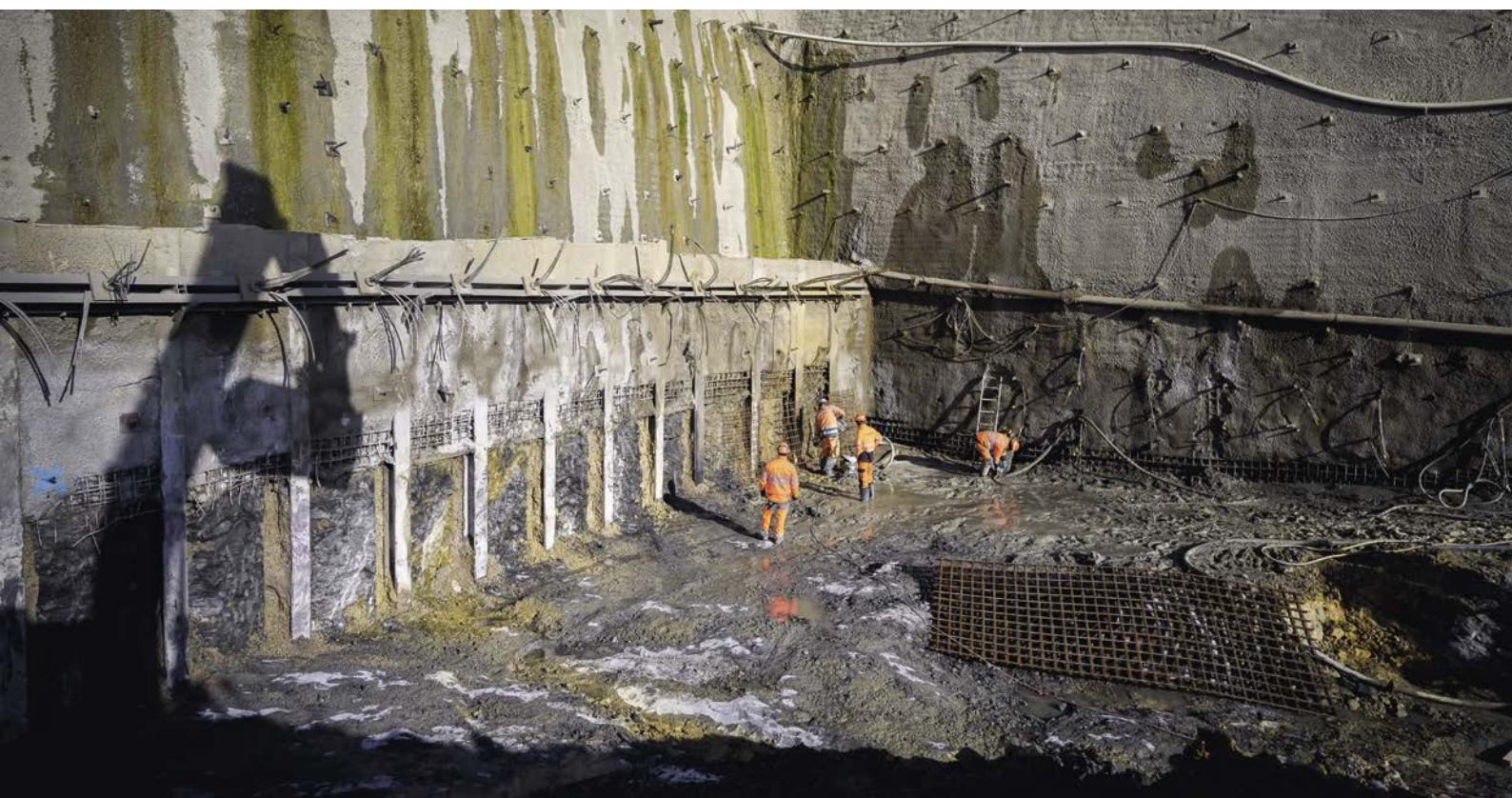
FA25: Lavori di costruzione Ligerz–Twann, nuovo galleria doppio binario
