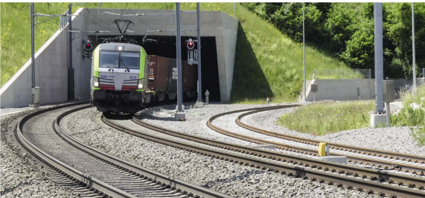
C4m: Portale dell’ nuovo galleria del Bözberg
