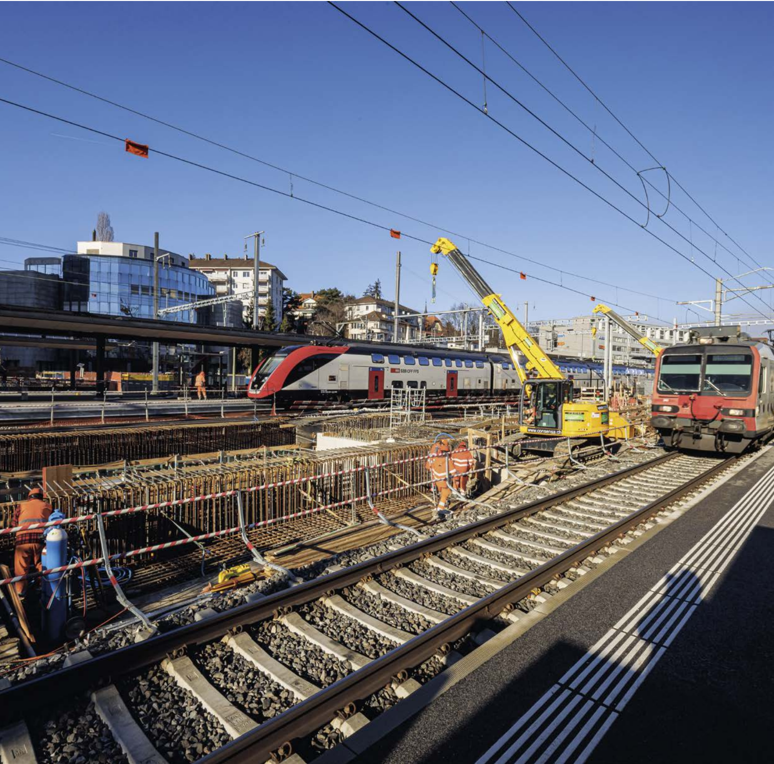
SIF: Fribourg/Freiburg: stazione: 2° sottopassaggio pedonale
