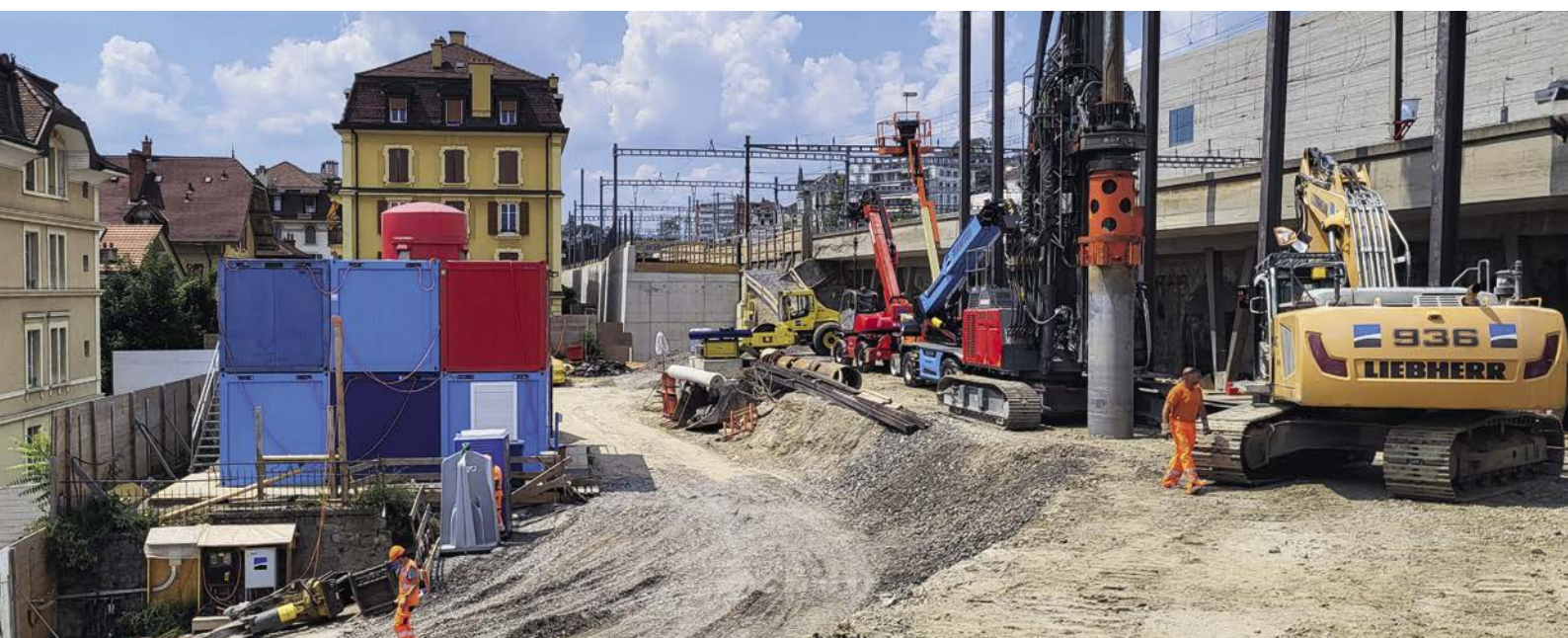
SIF: Lavori di costruzione del nuovo parcheggio multipiano «Epinettes»
