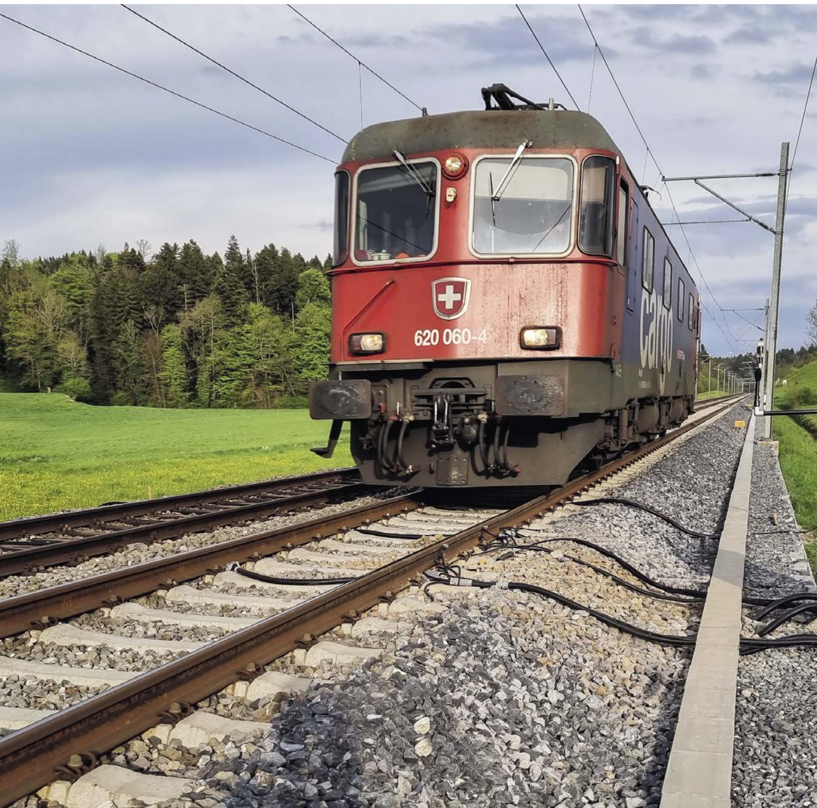
Sempach-Rotenburg: Laboratorio sulla sede ferroviaria (tratta di prova)
